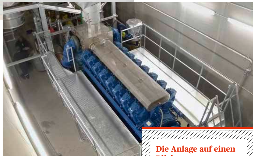
Drei BHKW von MWM liefern die Wärme für den Trockner
